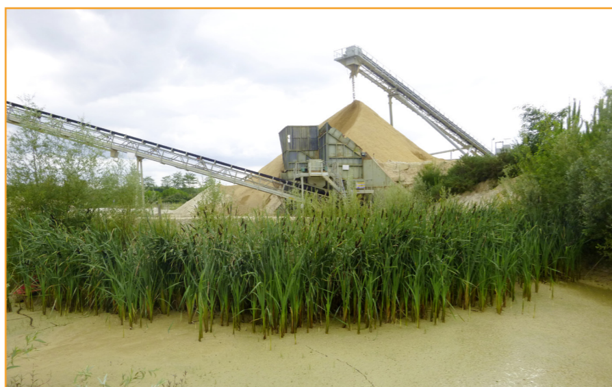
Installation de traitement, carrière d'Illats (Gironde).
