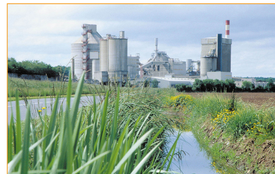
Cimenterie de Beffes (Cher).
