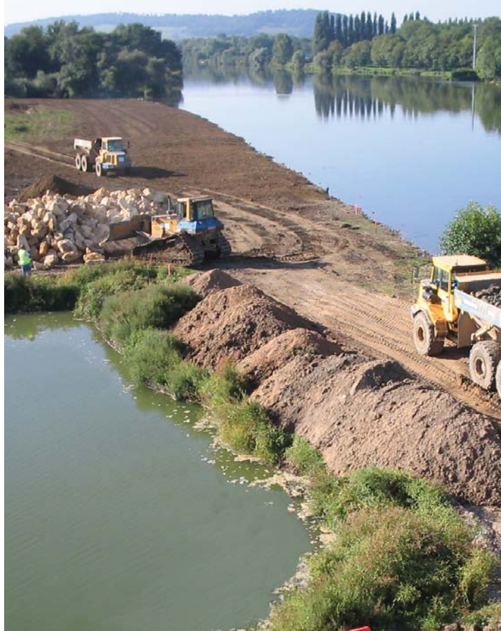
Travaux préparatoires à l'ouverture du port d'escale sur la Moselle
