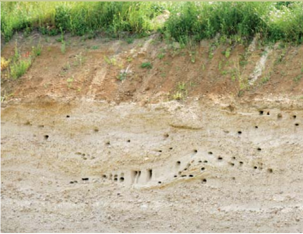
Front de taille aménagé pour la nidification d'hirondelles de rivage / Varennes-sur-Seine (77)
