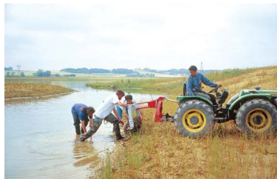
Mise en place de nappes pré-ensemencées de phragmites
