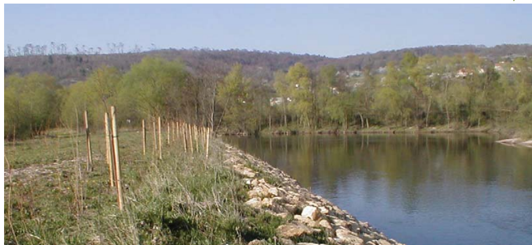
Réalisation : berge enrochée et végétalisée / Sexey-aux-Forges (54) ▼
