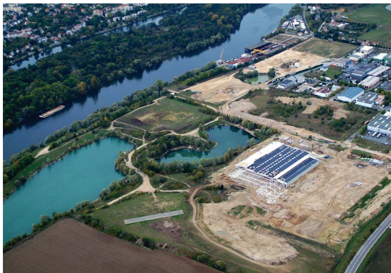
Construction d'une zone commerciale à Achères (78)
