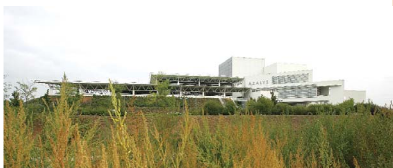
Centre de valorisation de déchets ménagers Azalys / Carrières-sous-Poissy (78)
