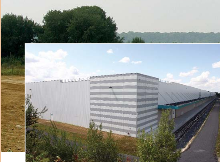
Plateforme logistique / Bruyères-sur-Oise (95)
