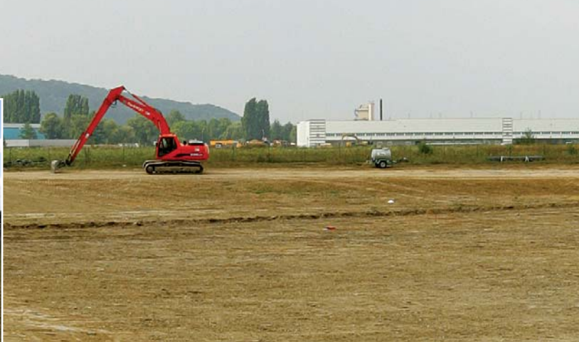
Travaux de terrassement / Bruyères-sur-Oise (95)
