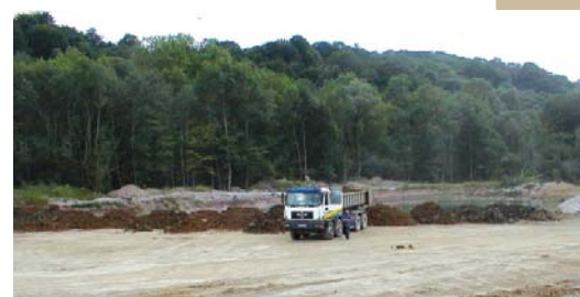
Mise en place et...
