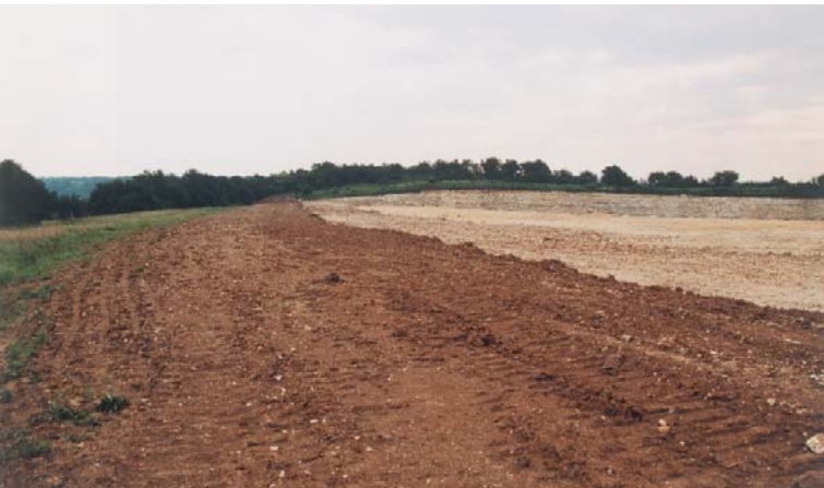
Remise en place de la terre végétale
